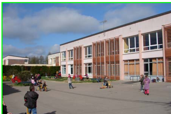
Derniers travaux, pose de pare soleil en terre cuite
